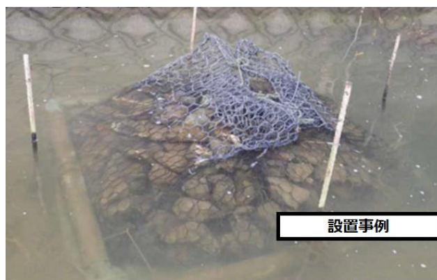
図 3. 石倉カゴ設置事例
