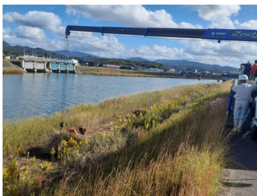
クレーンによる搬出
