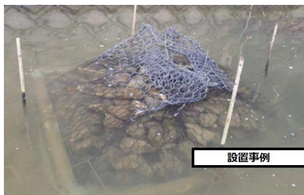
図 3. 石倉カゴ設置事例
