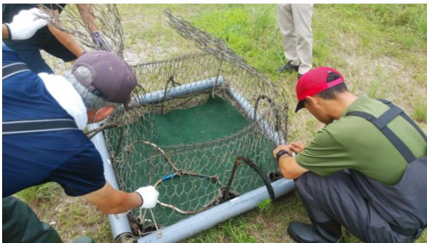
石倉かごの組立の様子
