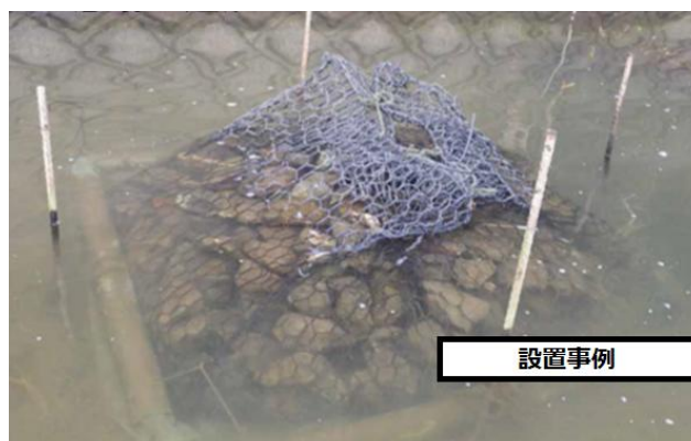
図 3. 石倉カゴ設置事例
