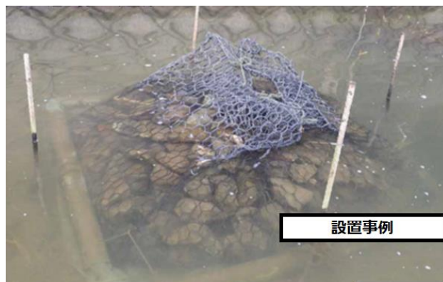
図 3. 石倉カゴ設置事例
