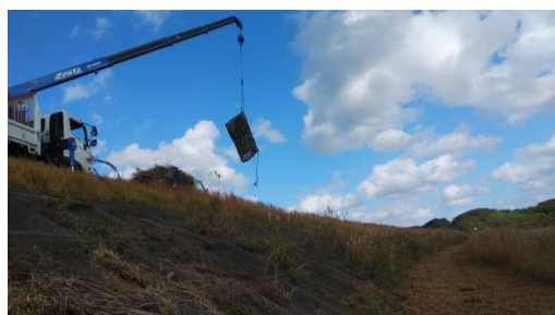
クレーンによる搬出
