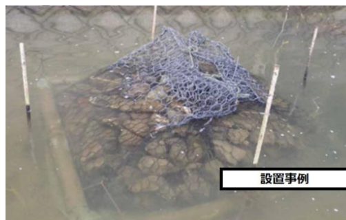
図2. 石倉カゴ設置事例
